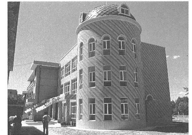
増設を支援したハルビンの幼稚園園舎
